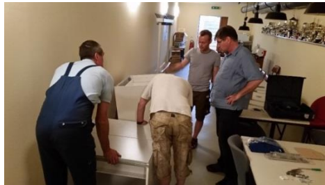
Arbeitseinsatz zur Renovierung des „Schlauches“ 2015
